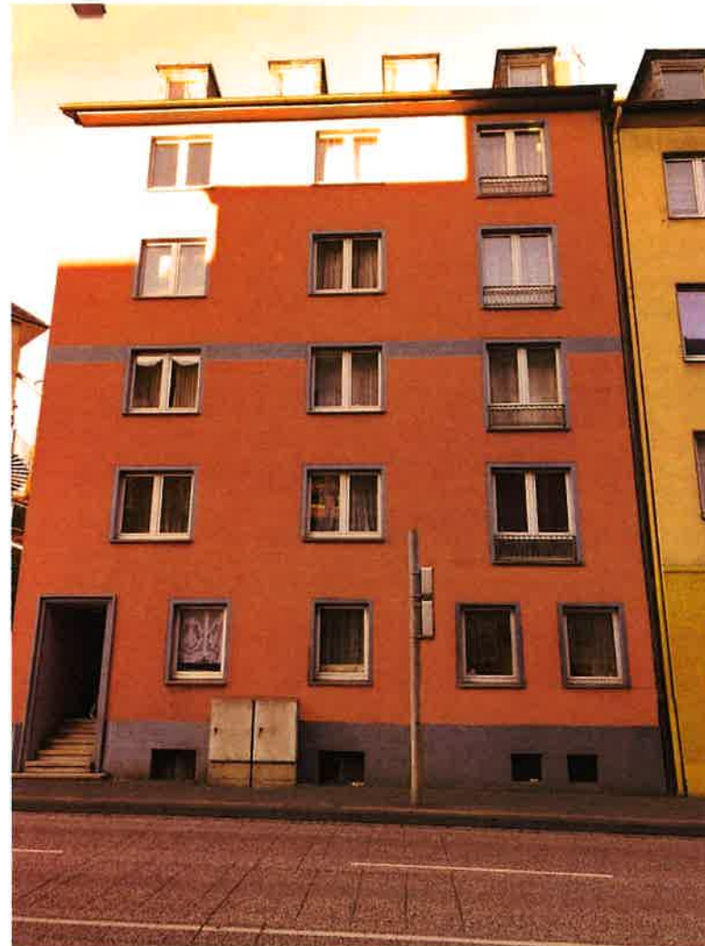
Foto vom Objekt Strassenseite
